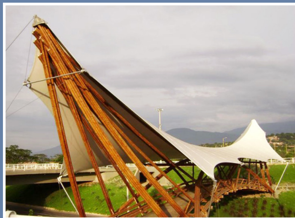
31 meter, Arch + Cable Stade Bridge, Cucuta - Colombia 2006
