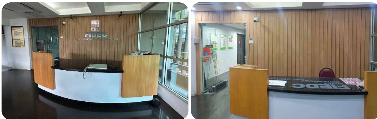
Hasil demonstrasi pemasangan WPC sebagai wall panelling di ruang lobi FIDEC 1
