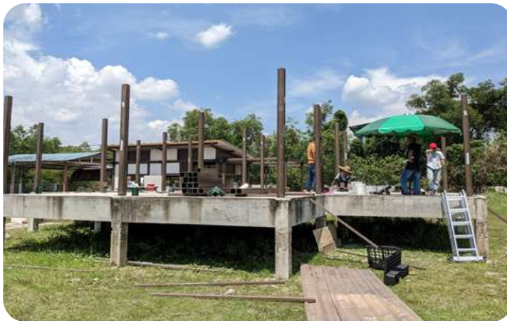
Kerja pemasangan metal reinforced WPC sebagai tiang utama rumah
