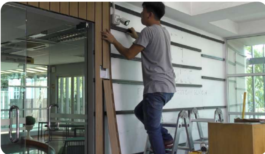
Peserta sedang mendengar penerangan dan melihat sendiri demonstrasi pemasangan WPC sebagai panel dinding sempena Program Embarking On The Journey: Potential Of Wood Plastic Composite (WPC)
