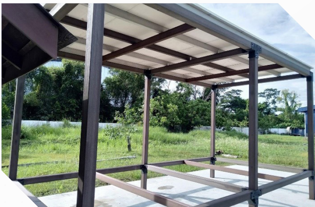
Pemasangan bumbung menggunakan cement board
