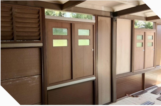
Mix and Match penggunaan komponen WPC untuk dinding dan tingkap
