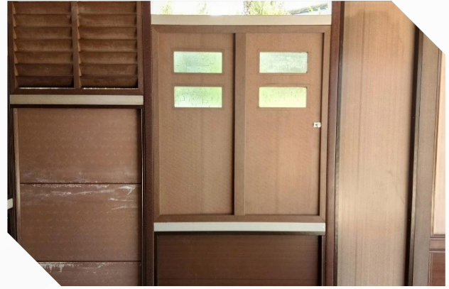
Mix and Match penggunaan komponen WPC untuk dinding dan tingkap
