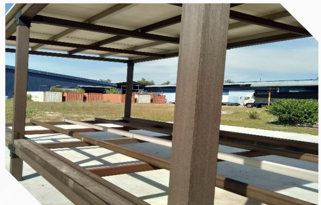
Pemasangan bumbung menggunakan cement board
